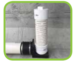
Drain Down Module
